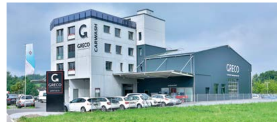
Der Neubau in Sirnach wurde 2016 eingeweiht.
